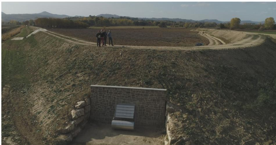
Figura 2 - cassa d'espansione realizzata in Località Salcheto, scarico di fondo alla confluenza del torrente. Salcheto e del torrente. Ciarliana tramite valvola antiriflusso a galleggiante.
